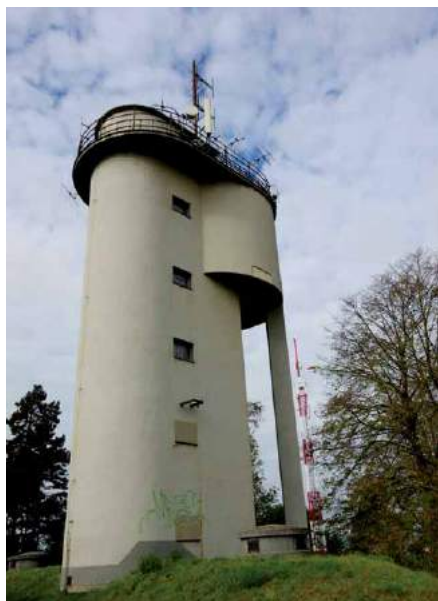
Vodojem Kostelíček. Foto: Ing. Jaroslav Hedbávný
