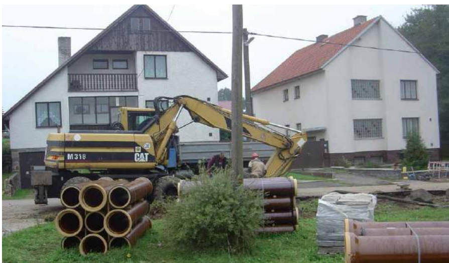
Stavba kanalizace v úseku Měřín-Pustina
