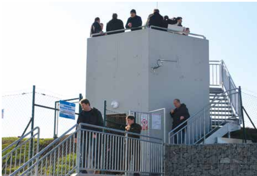
Na vyhlídce z nového boskovického vodojemu
