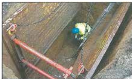
OPRAVIT propadlou vozovku bylo možné jen s pomocí vytyčení. Foto: autor
