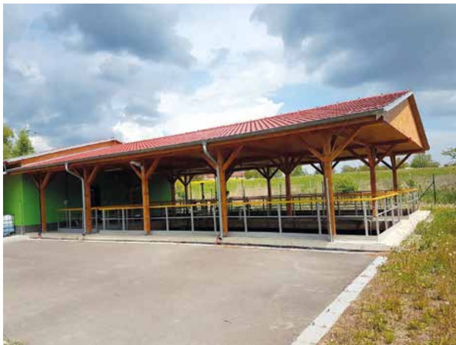
Nově postavená čistírna odpadních vod v Branišovicích
