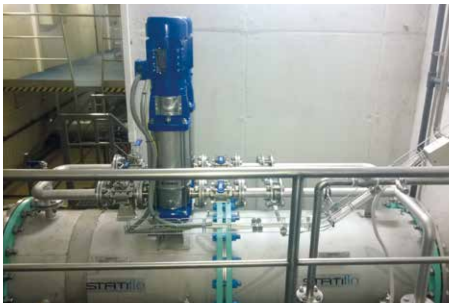
Statický měřič Statiflo na úpravně vody Hosov.
